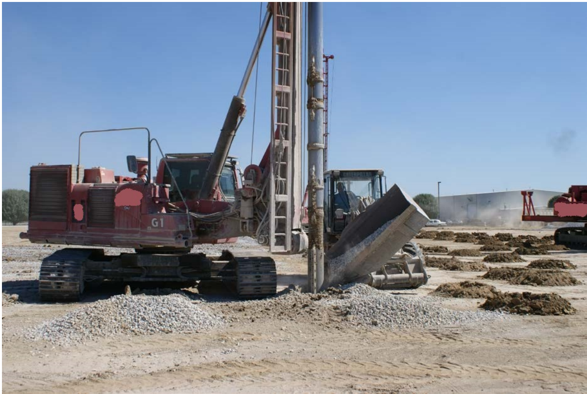
Figure 5-9. Top feed vibro rig.
